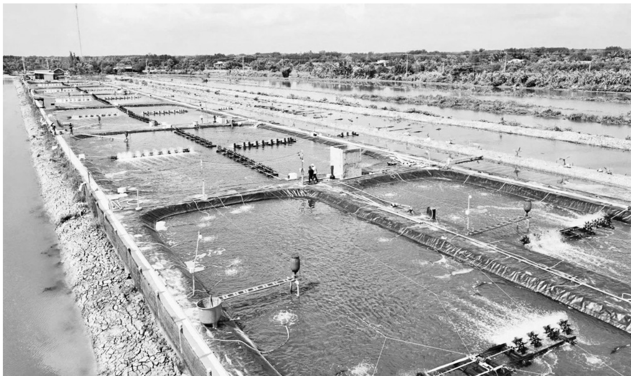
Khu nuôi tôm công nghệ cao áp dụng mô hình tuần hoàn nước tại Cà Mau
